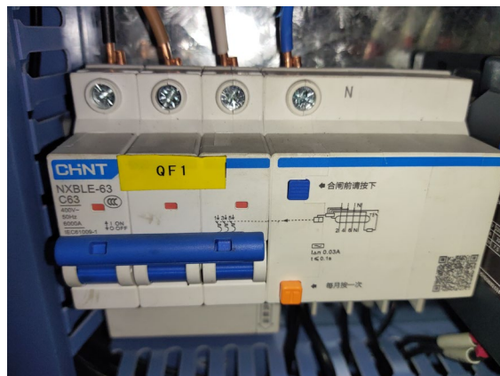
Рис. 5 Схема подключения 380V (защитная линия + защитная линия + нулевая линия).
