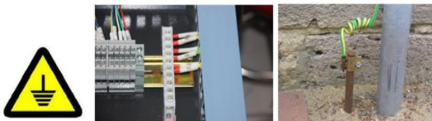
Рис. 6 Подключение заземления
