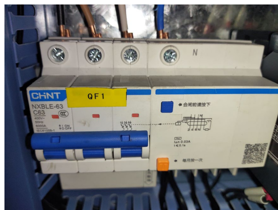
Рис. 4 Схема подключения 380V (защитная линия + защитная линия + нулевая линия).
