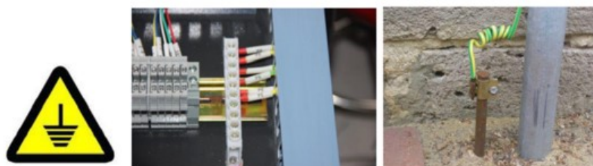
Рис. 5 Подключение заземления
